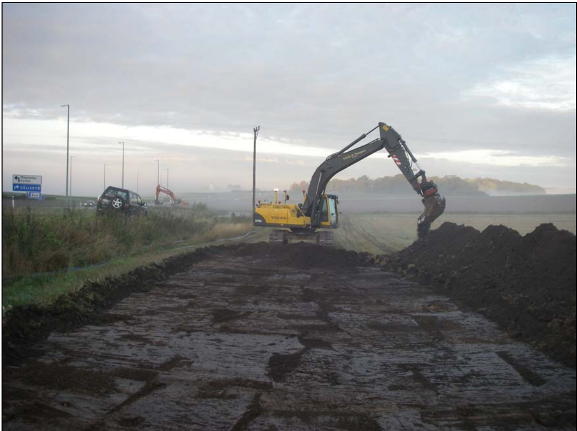
Bilaga 1b – Schaktning för vattenledning i närheten av Vallby.
