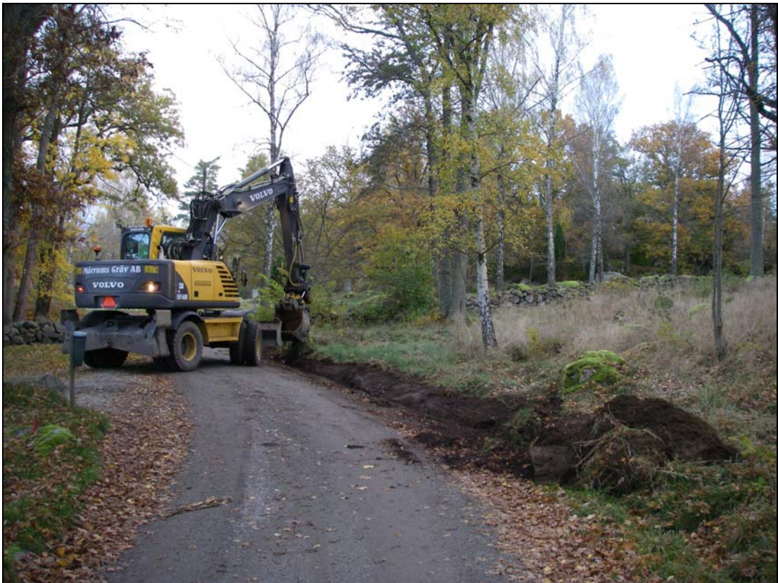
Bilaga 1b – Dräneringsshakt fotograferat mot NO.
